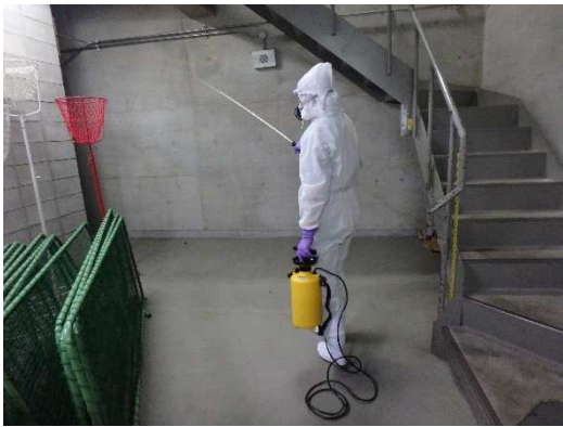
各倉庫消毒作業
